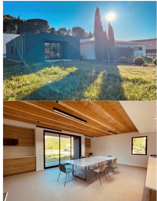
Photo 3 : Extension du laboratoire avec la nouvelle salle de dégustation
